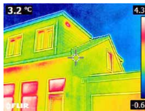
Op de voorbeeldfoto is het warmteverlies via de ramen op de benedenverdieping duidelijk zichtbaar.
