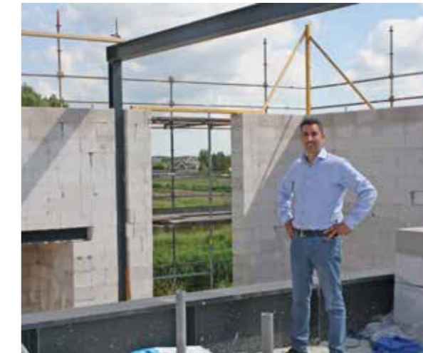
Nordin Nassla, voorzitter van stichting Ar-Rahma & Kleurrijk Assendelft, bij de Moskee in aanbouw
